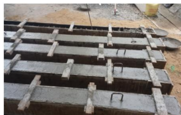
6(e) Pouring of Concrete
