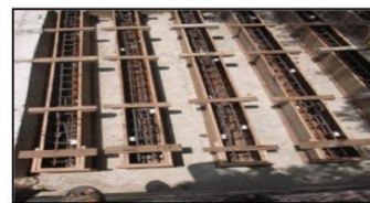
6(d) Beam Mould Ready for Casting
